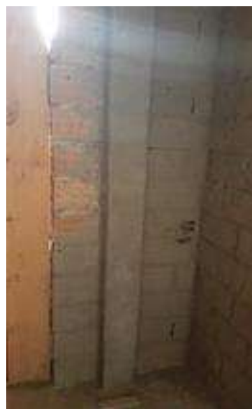
Figura 20– Apresenta a incompatibilidade encontrada no Ponto 3 em campo.
